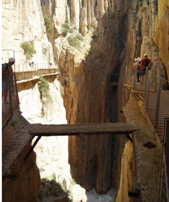
Die Reste des alten Weges sind gut erkennbar
