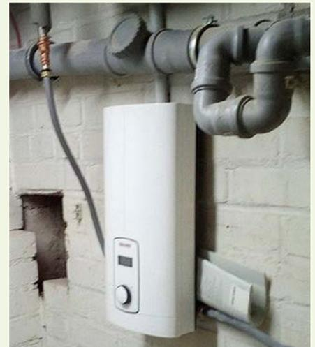
Um unserem Ziel näherzukommen, die Hütten der Sektion weitgehend umweltverträglich zu führen, wurde der Warmwasserboiler durch einen Durchlauferhitzer ersetzt. Dadurch muss im Sommer die Ölheizung nicht laufen. Wir erwarten eine deutliche CO<sub>2</sub>-Reduzierung durch eingespartes Öl.
