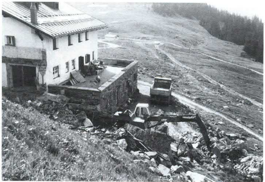
Abb. 41 Der Bagger schafft im August 1982 Raum für den Ausbau des Kölner Hauses
