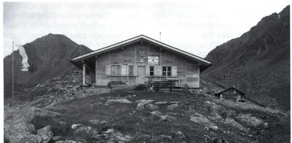
Abb. 48 Die Neue Hexenseehütte auf 2.650m über NN oberhalb des Hexensees
