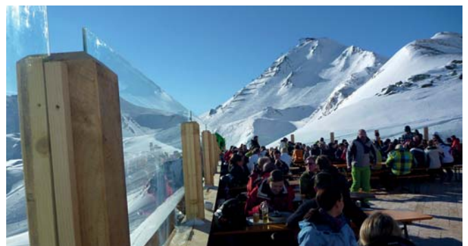
Blick von der neuen Terrasse zur neuen Seilbahn auf den Masner
