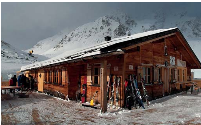
Hexenseehütte mit der neuen Terrasse
