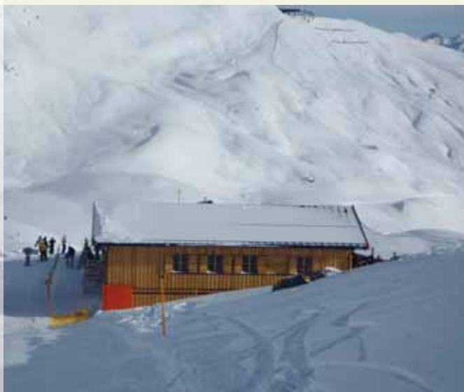
Die neue Anbau der Hexenseehütte von Westen
