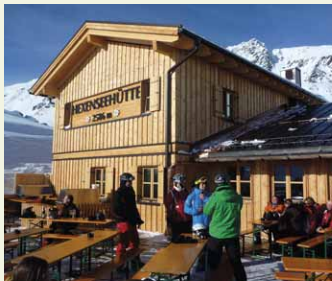
Die Hexenseehütte – der neue Anbau
