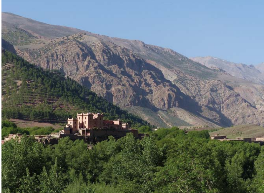
Die Kasbah im Ait-Bougoumez-Tal ist aus Stampflehm gebaut.
