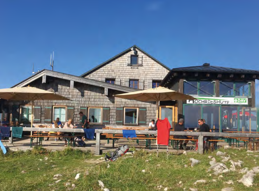
Die moderne Hochrieshütte
