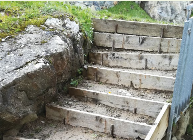
Notausgangstreppe am Kölner Haus neu fixiert
