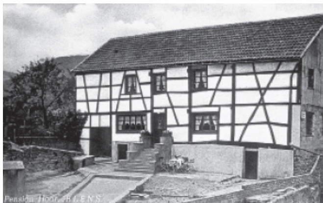
Pension Hoor vor der Übernahme durch die Sektion
